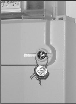
**Abb. oben:** Benutzersicherung für den Klemmendeckel (per Plombe)
