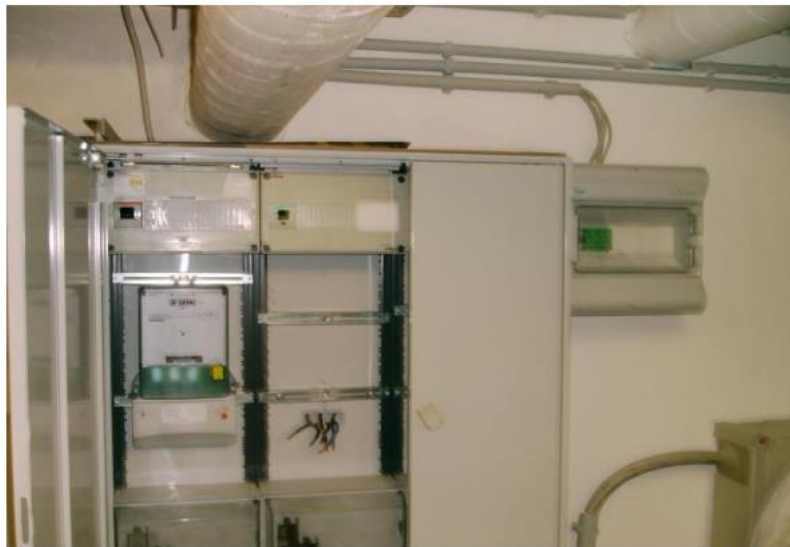
Abbildung 1: Beispielhafte Darstellung einer Trennstelle Strom
